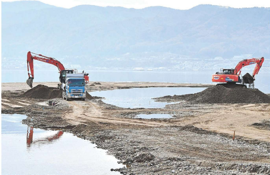
砥川河口付近で行われている浚渫作業＝下諏訪町
